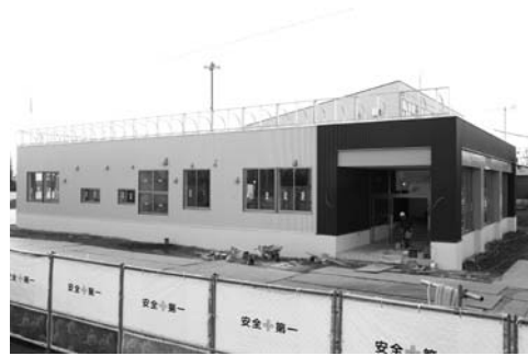
第5ふれあいセンター建設工事
