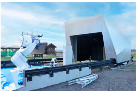
↑ 建物がスライドした時の様子。望遠鏡が現れ、360度の観望が可能です。
