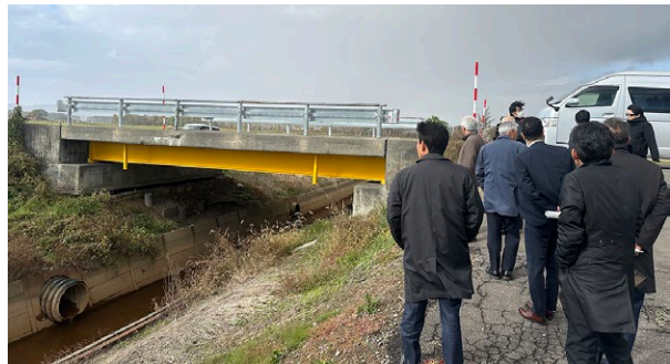
北6号第45線橋塗装工事現場
