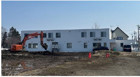
旧病院の解体工事を終えたすこやかクリニック
