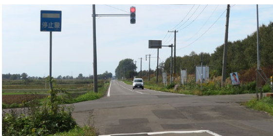
整備が進められている村道新湧西原線 (通称、広域農道)
