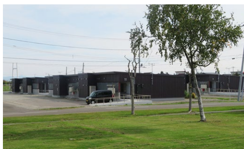
整備が完了した公営住宅南団地
