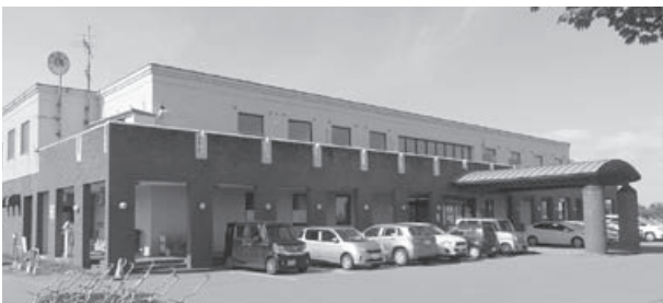
老朽化により解体が検討されている旧しんしのつ温泉アイリス
