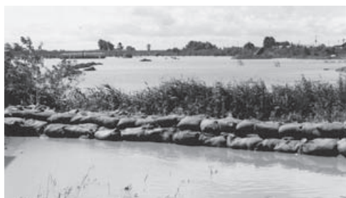
内水被害を食い止める土のうが積まれた運動公園（昭和56年8月）
