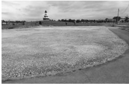
キャンプ場の駐車場造成のために改修されたパークゴルフ場
