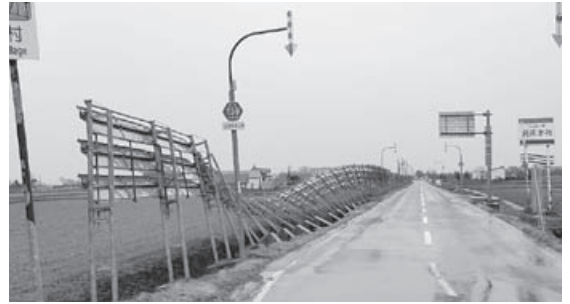
強風により倒れた防雪柵 (12月1日)
