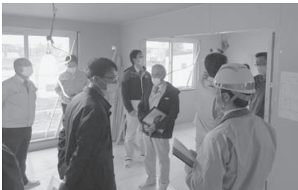
南団地8・9号棟建築工事現場
