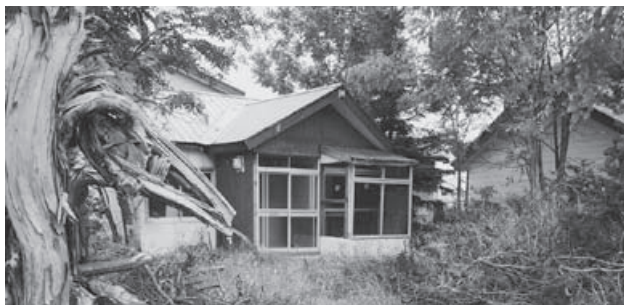
倒壊の危険がある市街地に放置された空き家
