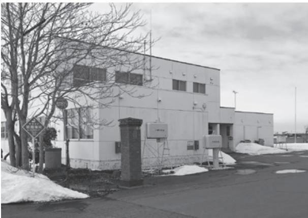
築41年が経過した改修予定の第3地区集落センター
