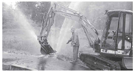
水道管の漏水工事を指示する月新水道企業団職員
