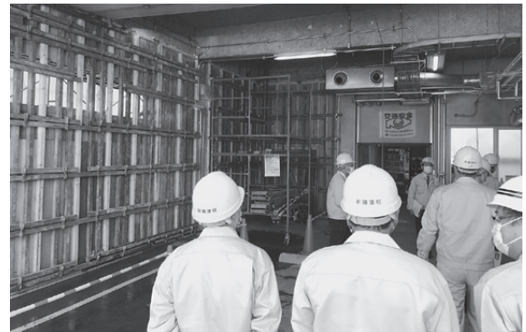
工事が進んでいた消防署耐震改修工事現場
