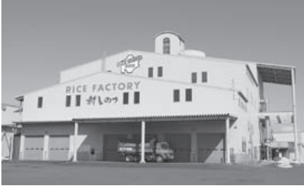
調製能力向上のため、出荷設備を整備する予定のライスファクトリー
