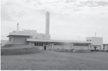
解体予定の北石狩衛生センターのし尿処理棟
