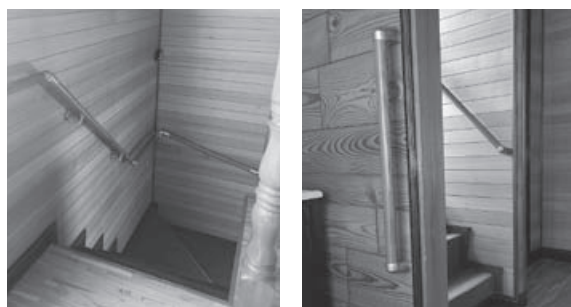
介護保険の住宅改修費を利用して手すりを付けた住宅
