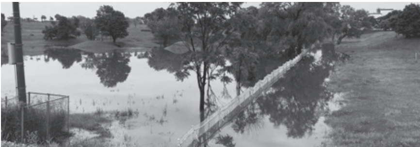
大雨時、市街地の集水地となる冒険公園
