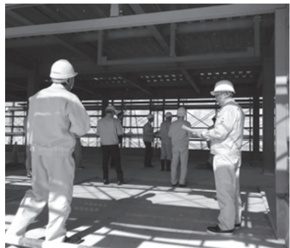
工事が進む第4地区社会教育会館建設現場
