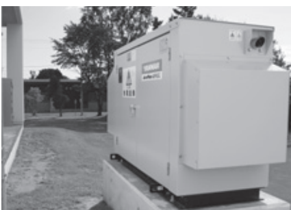
自治センターに設置された非常用発電機と小型発電機
