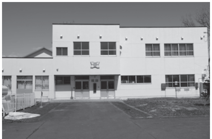
昭和56年建築の改築予定の第4地区社会教育会館
