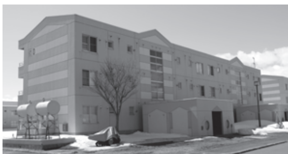
塗装工事が予定されている西団地D棟
