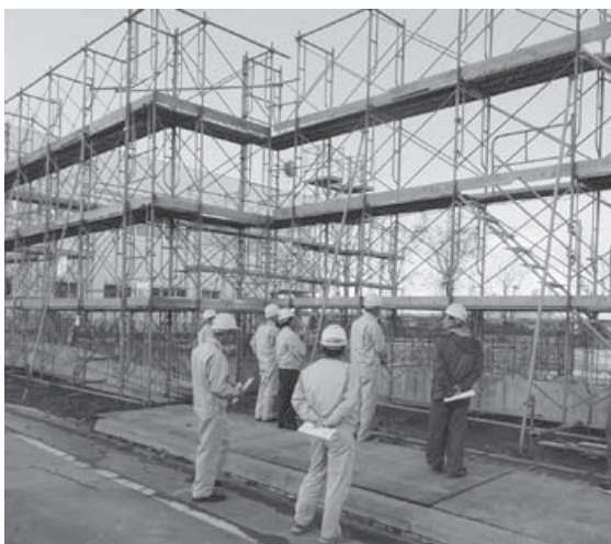
村営プール建設現場を視察
