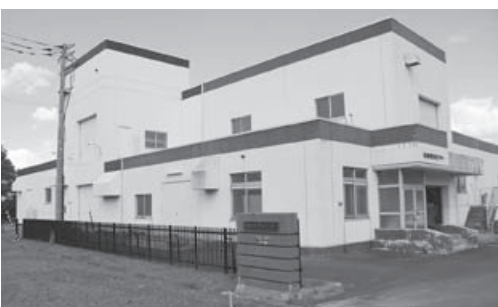
浄化センター
