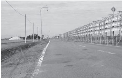
41線付近の基線道路
