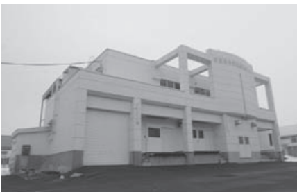
煙突改修工事が予定されている給食センター
