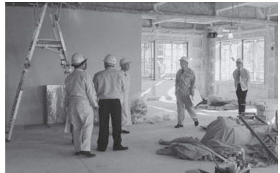
第5地区ふれあいセンター工事現場
