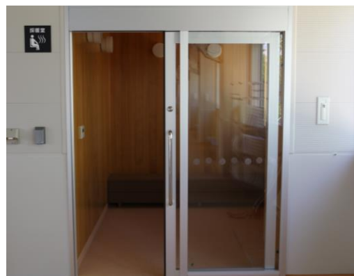
多目的トイレ
