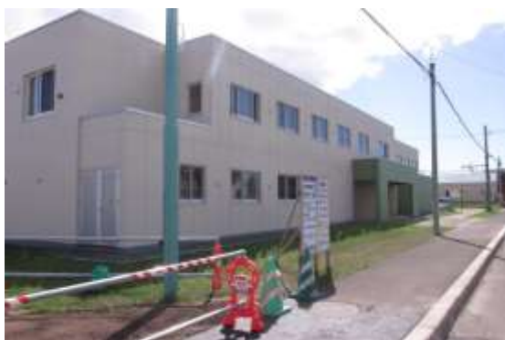
▲公営住宅の外観。2階建 1棟8戸。
